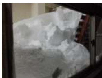
1F廊下の窓を塞ぐ屋根雪 (2/9 撮影)
